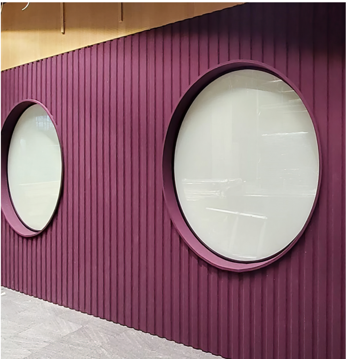
Lamele w formie blachy trapezowej naklejane na pełny panel oklejony 1 mm filcem wełnianym w celu uzyskania docelowego koloru. Koła wykończone filcem
