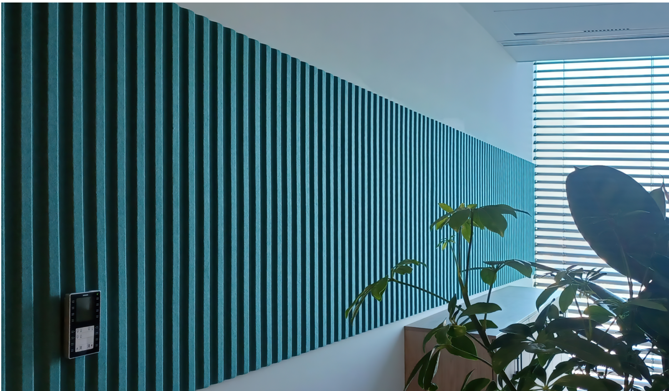
Zintra lamele w formie blachy trapezowej naklejane na pełny panel i oklejony 1 mm filcem wełnianym w celu uzyskania docelowego koloru, efekt lamperii
