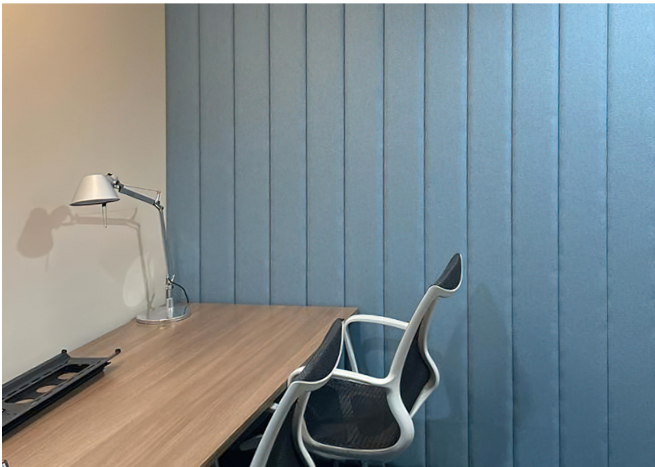
Lamele z gąbki akustycznej wykończone 1 mm filcem wełnianym, wzór indywidualny
