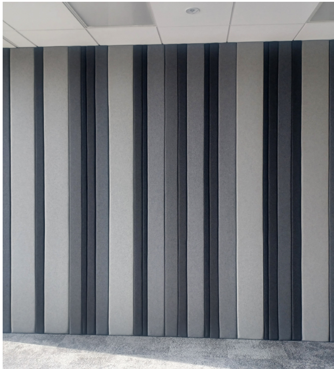
Lamele i wkładki z gąbki akustycznej wykończone 1 mm filcem wełnianym, wzór indywidualny
